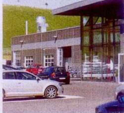
Die Werkstatt (L.) schließt sich an die Ausstellungshalle an
